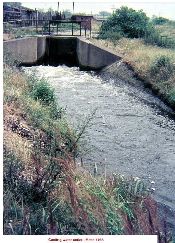
Most 1968 napájení venkovního bazénu
